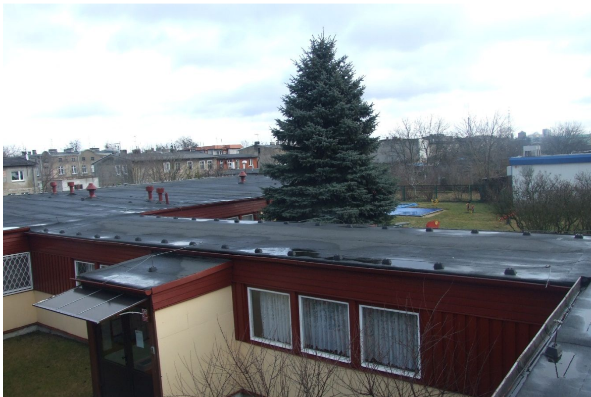
Widok dachu I
